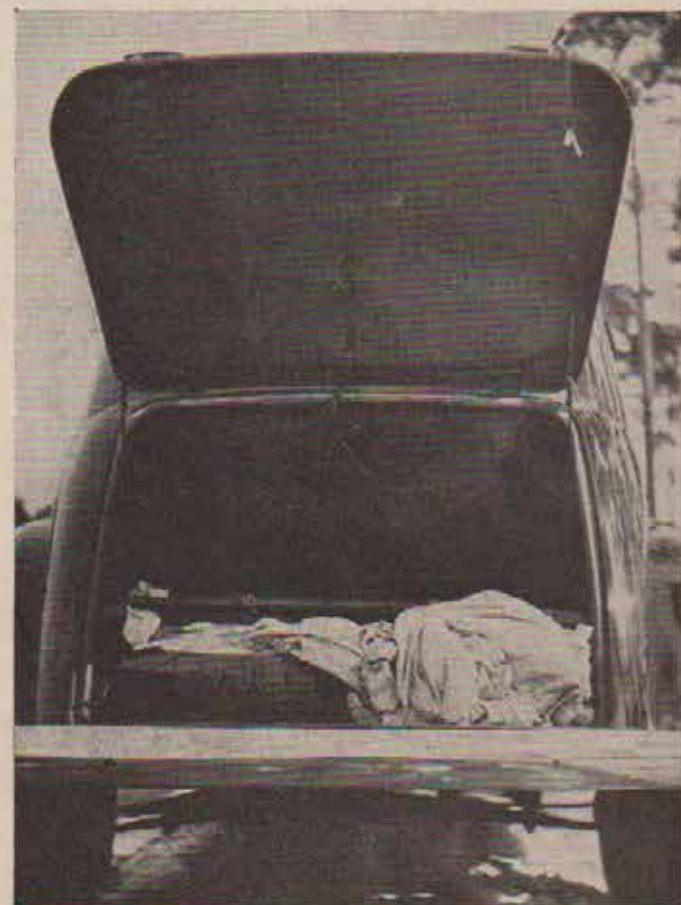
Zum Kofferraum gelangt man von außen; Reserve-rad und Werkzeug also auch unter Verschluss
