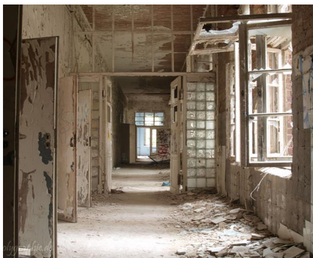
Zustand 2011 im Inneren der Chirurgie
