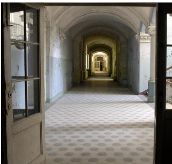
Zustand 2005 im Inneren der Chirurgie
