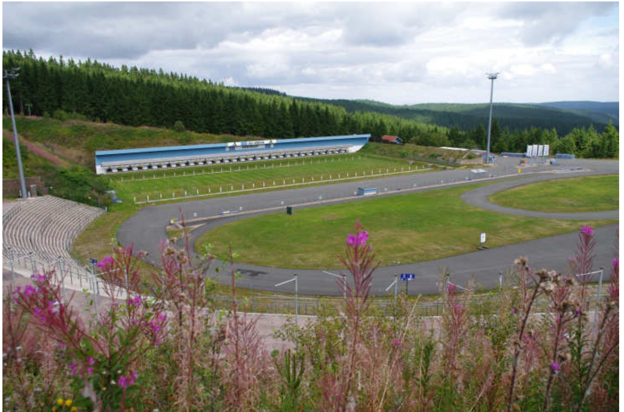
Besichtigung der Wintersportanlagen mit der Biathlonarena in Oberhof am Grenzadler
